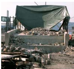
Steinsetting av gangbroen.
